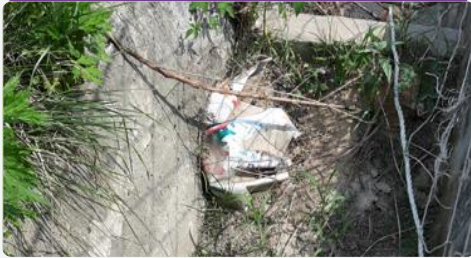
배수로 퇴적물로 유입물이 막힌 사례
