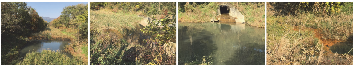
[그림 6] 1지점과 2지점 사이에 설치된 보와 갈대 및 오염 상태
