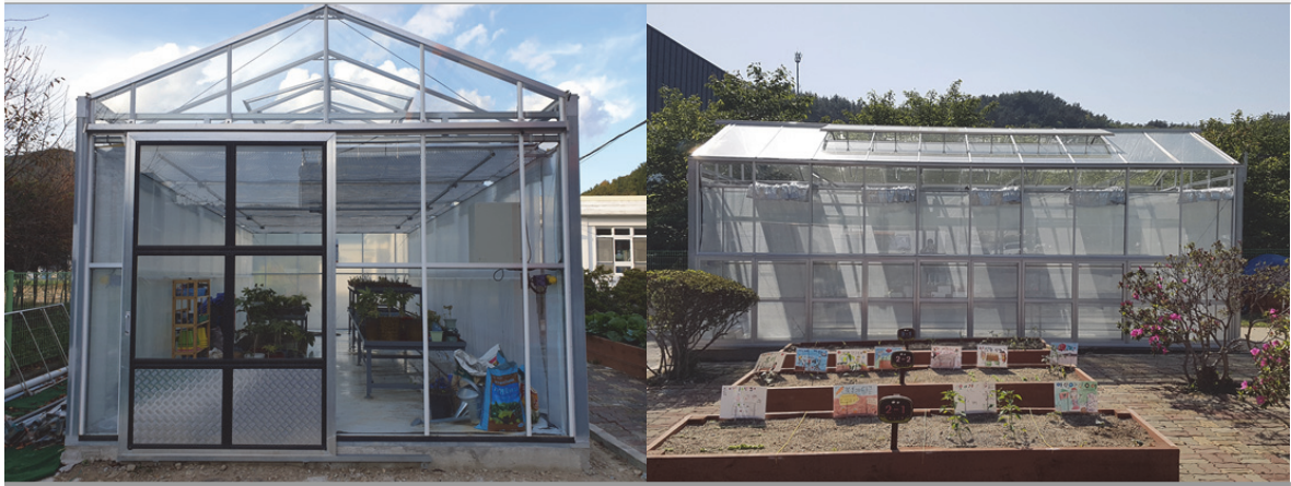
에코 웨어하우스 조성 사진
